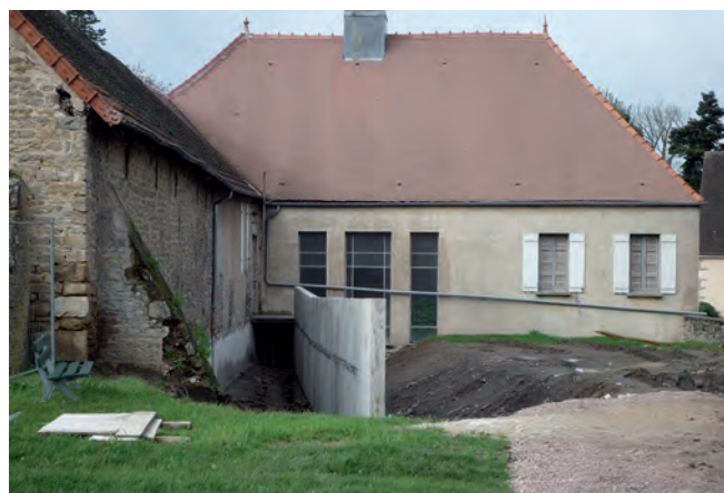
Le futur accès de la mairie
